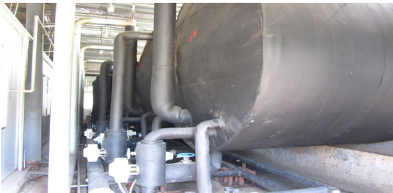
图2 卧式发酵装置
