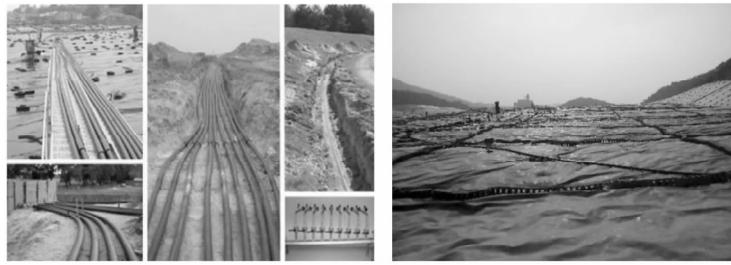
图1 辽宁省某处垃圾填埋场作业过程中填埋气高效收集系统工程现场照片
