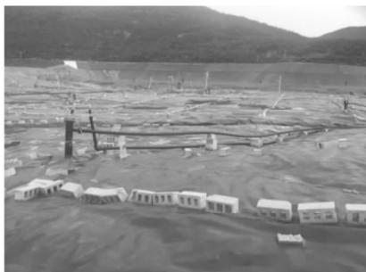
图2 福建省某处垃圾填埋场竖井高效收集系统工程现场照片
