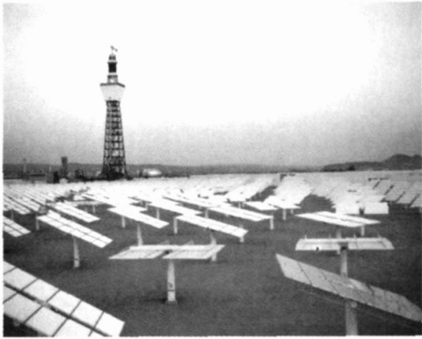
图 2 塔式太阳能热发电站
