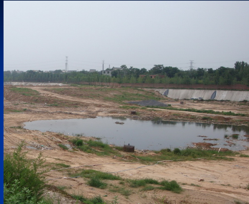
郑州垃圾场——中间覆盖层上积水蓄积成了渗滤液
