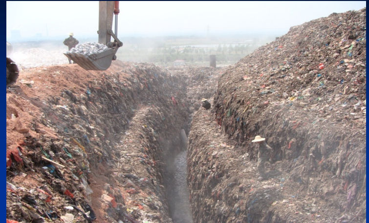
开挖水平槽
